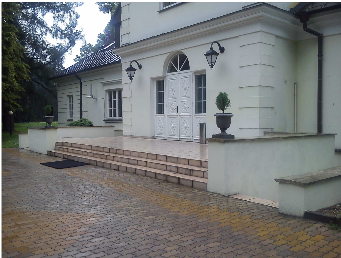
Widok schodów wejściowych – elewacja frontowa
