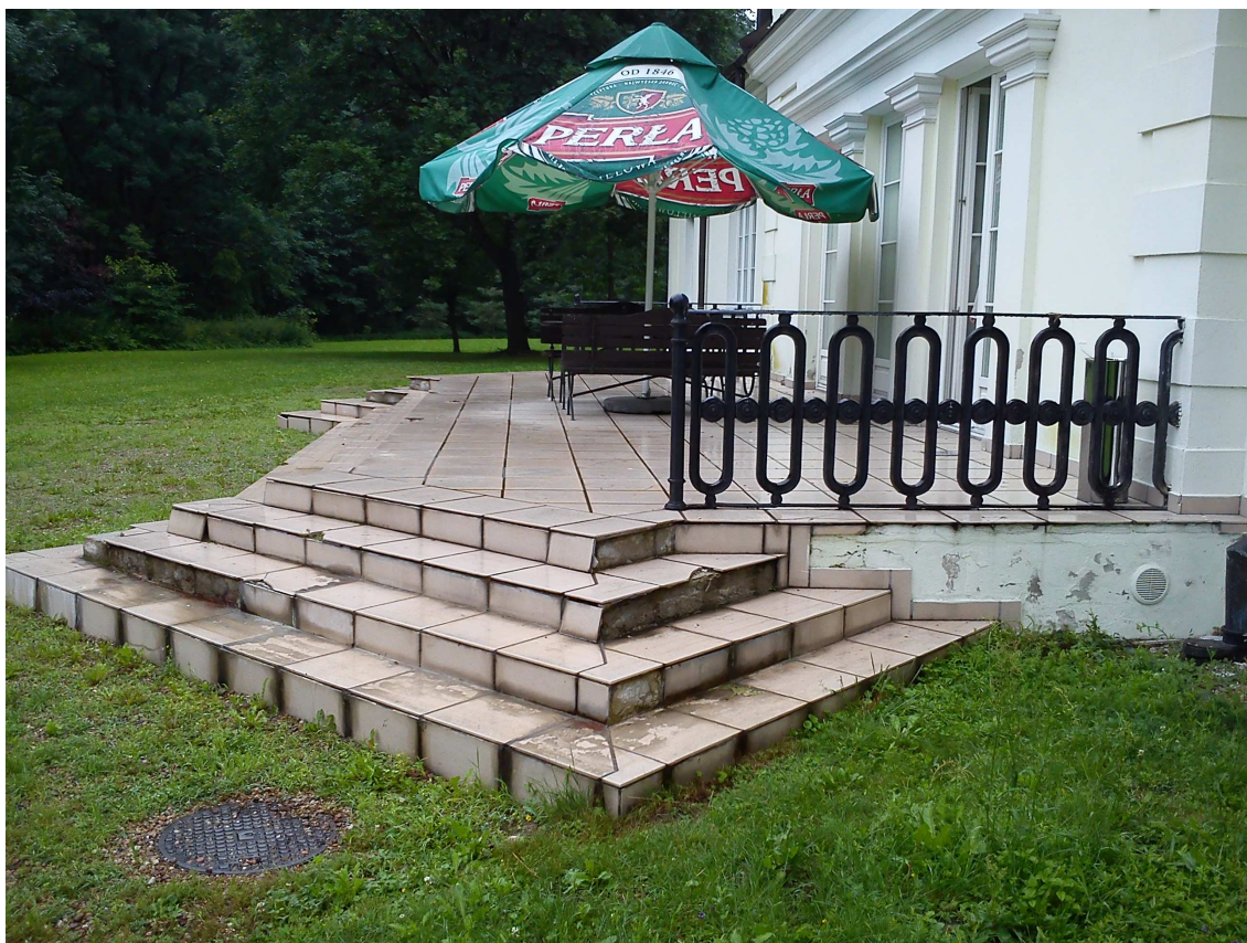
Widok tarasu – elewacja tylna
